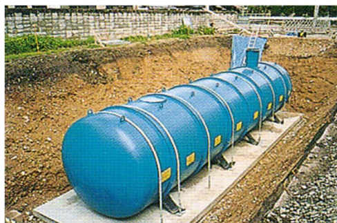
耐震性貯水槽
