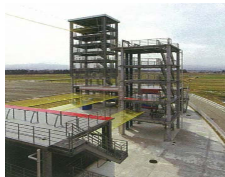
広域訓練拠点施設 (提供: 富山県広域消防防災センター)
